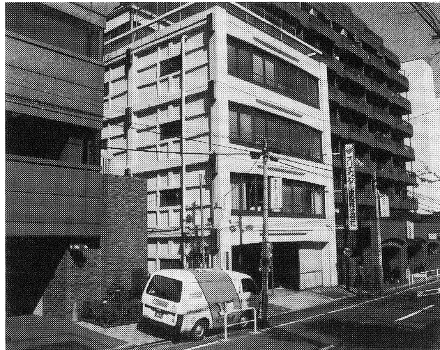
写真-1 解体前のオリエンタル建設本社ビル全景
