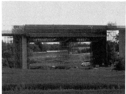
写真-1 施工写真
