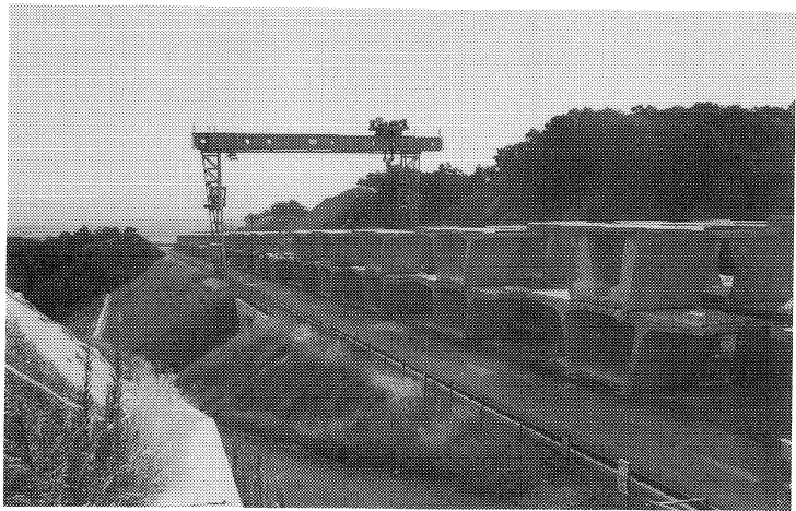
写真-3 セグメント仮置き状況
