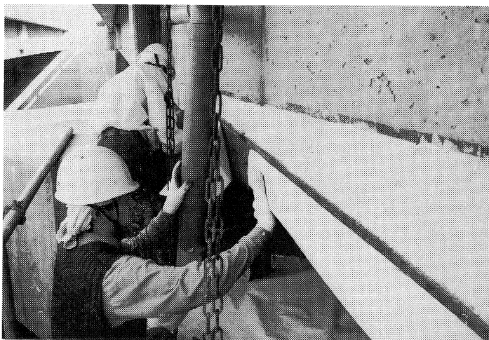
写真-3 CFシートの貼付状況（その1）
