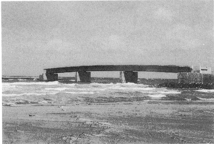
写真-1 橋体完成
