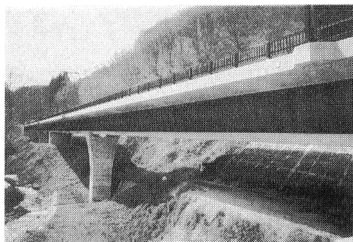
写真-1 完成写真
