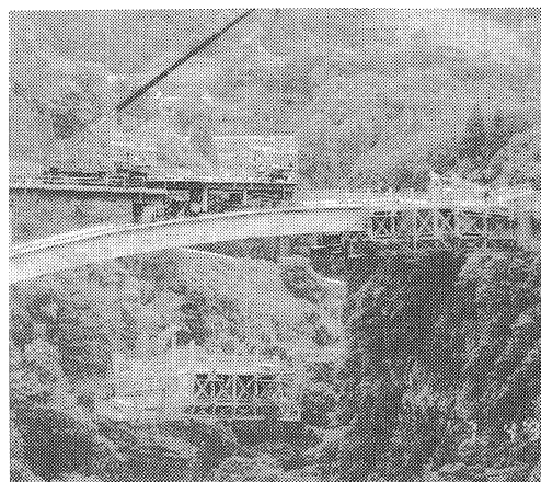
写真-6 特殊移動架設車解体
