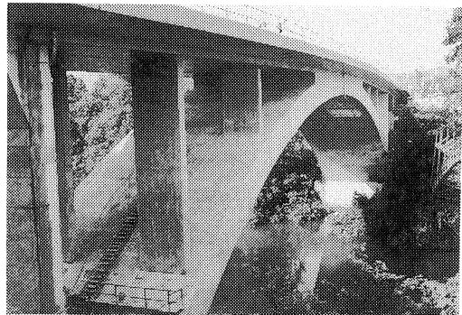
写真-6 橋体完成
