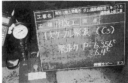
写真2 一次ケーブル緊張
