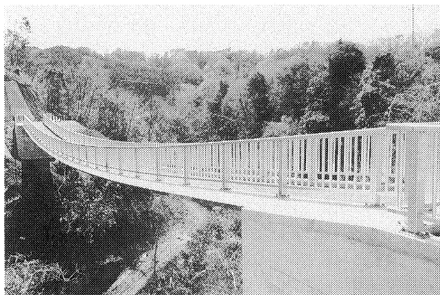
写真-1 片倉ダム林道5号橋全景
