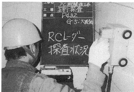
写真-1 調査状況
