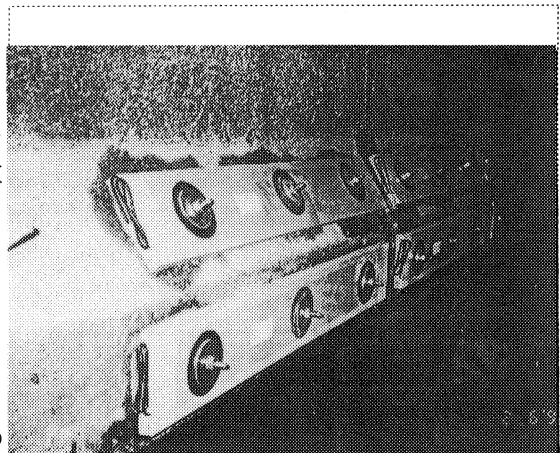
写真-3 電気防食板取付
