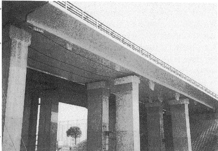
写真-2 小柳津高架橋(補強完了)
