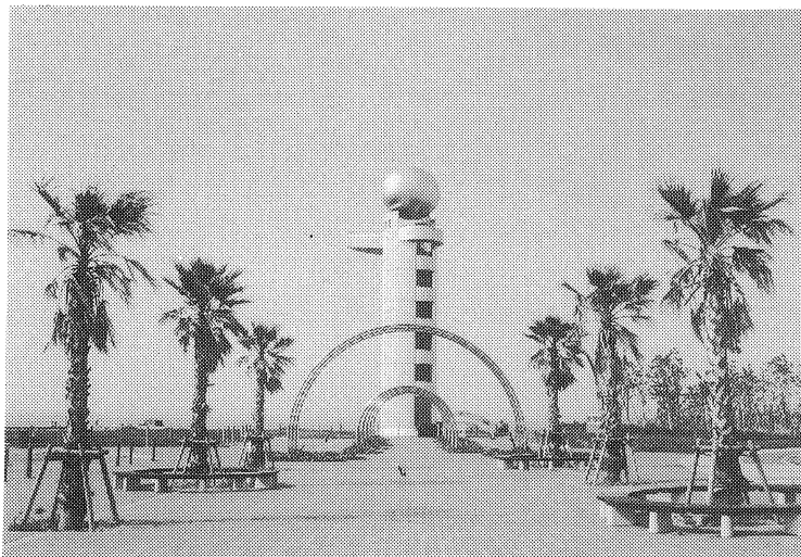
写真-3 完成写真
