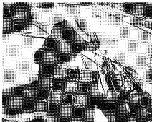
写真-6 床版ケーブル緊張状況
