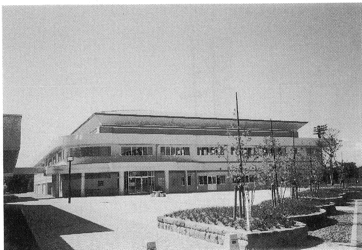
写真-1 建物全景
