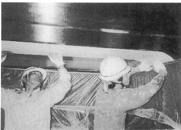
写真-2 炭素繊維シート貼付け状況
