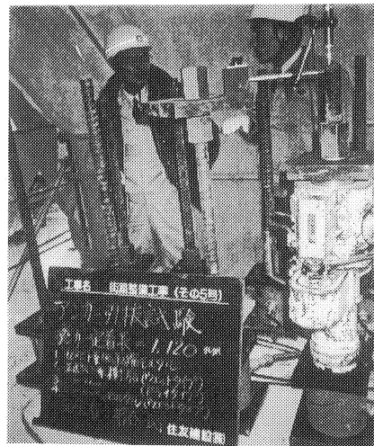
写真-1 引抜き試験状況
