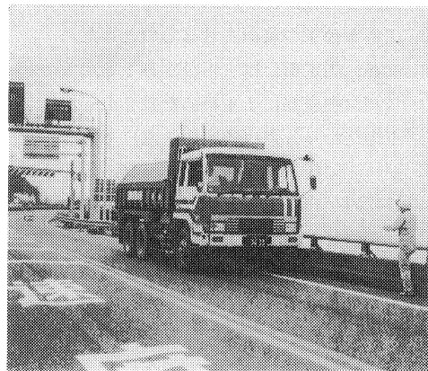
写真-7 ケース2 載荷状況
