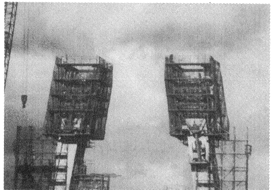
写真-1 施工状況
