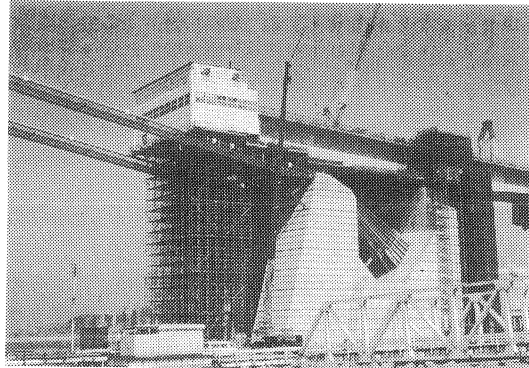
写真-5 P3張出し施工部作業床
