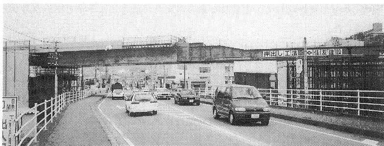
写真-2 押し出し施工状況
