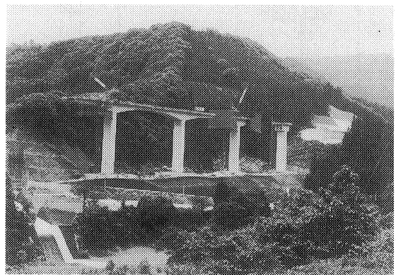
写真-3 P10～A2径間
