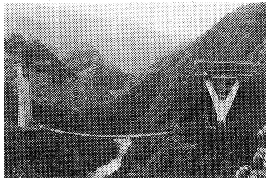
写真-1 施工状況
