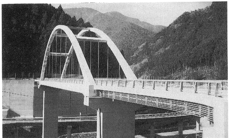
写真-1 完成状況
