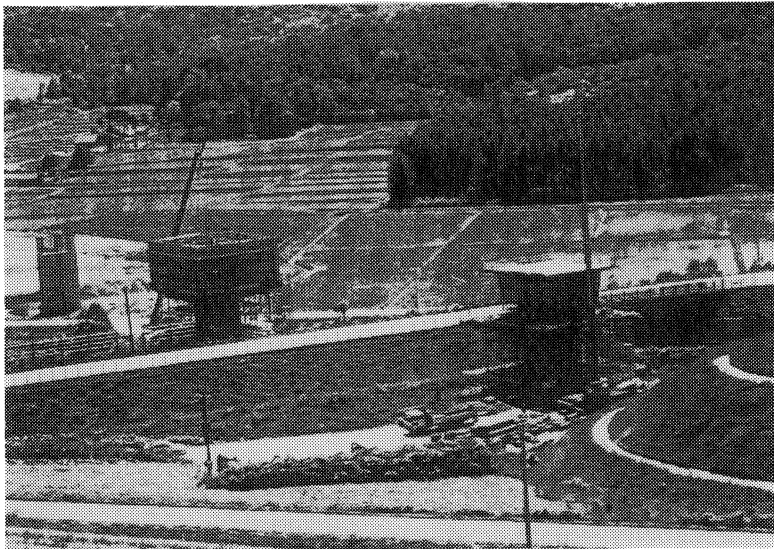
写真-1 施工状況
