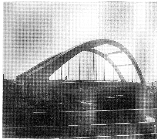
写真-1 完成写真
