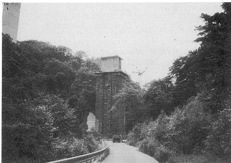
写真-1 施工状況
