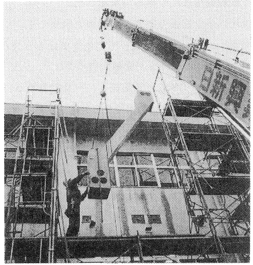
写真-5 部材吊り上
