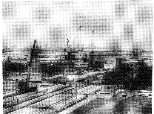
写真-3 架設状況
