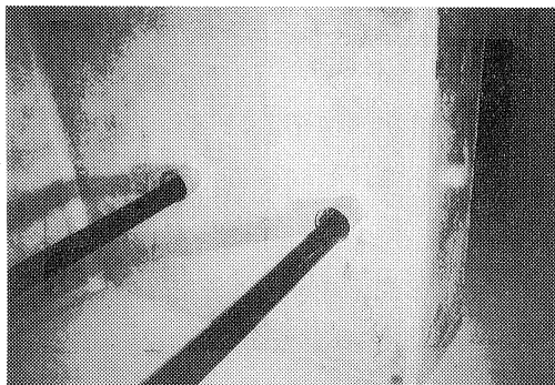
写真-8 外ケーブル偏向部
