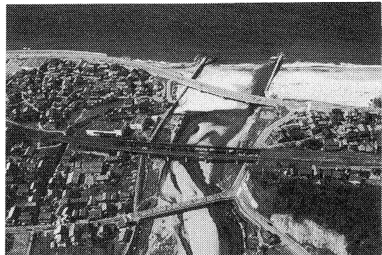
図-1 橋りょう全景
