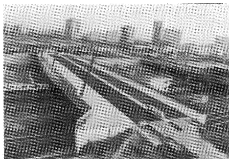
写真-4 完成状況
