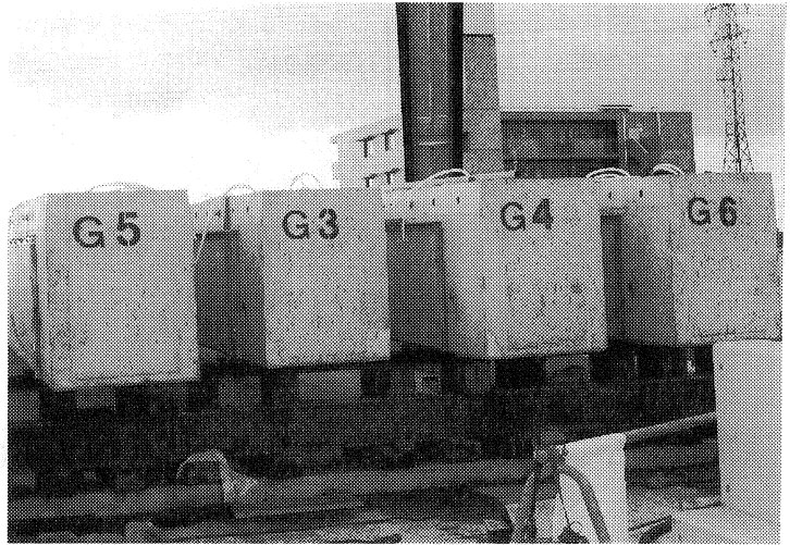
写真-2 主桁仮置き状況
