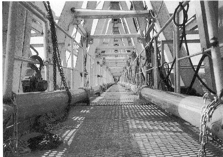
写真-3 前方吊型枠による柱頭部の施工状況
