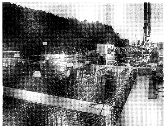
写真-4.3 引き出し状況
