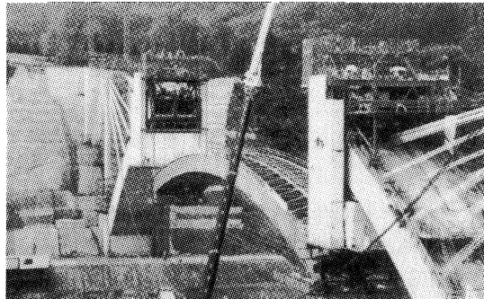
写真-5 一括架設状況(右岸より)
