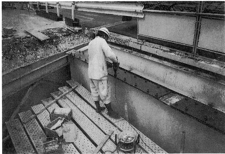
写真-2 固定状況
