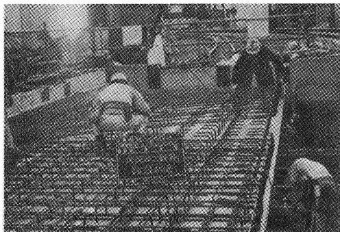
写真-2 床版ユニット鉄筋の配置
