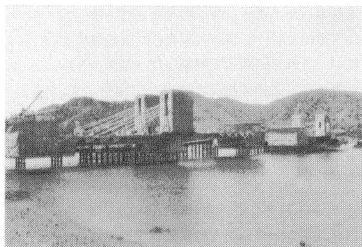
写真-1 張出し架設状況
