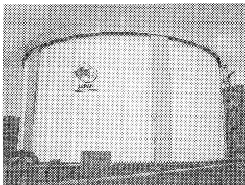
写真-1 第1配水池完成写真
