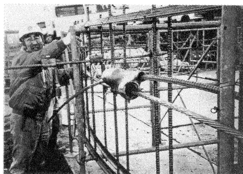
写真-3 施工性試験
