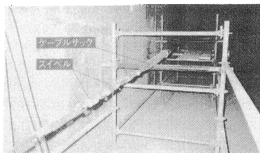
写真-3 挿入状況
