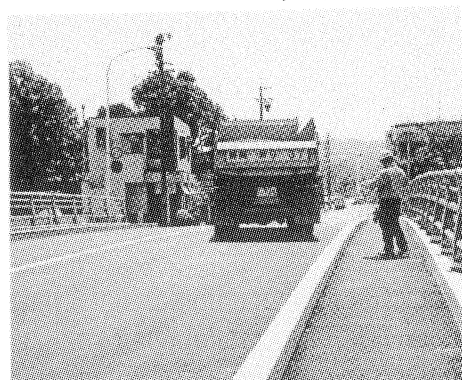
写真-7 載荷試験状況
