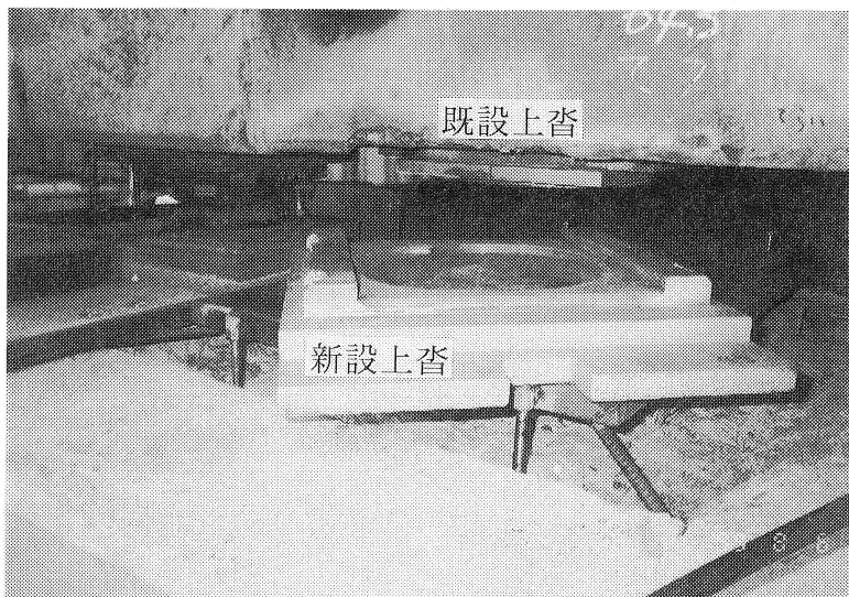
写真-2 支承交換状況
