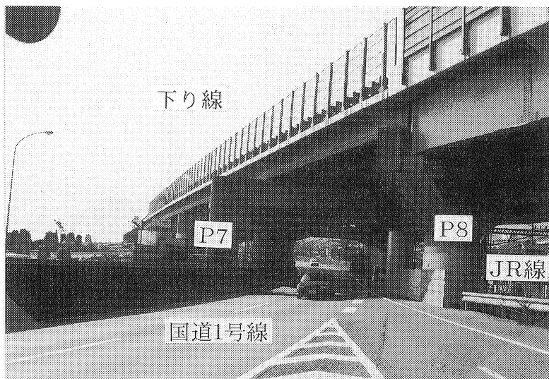
写真-1 施工前全景
