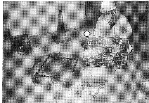
写真-6 スランプフロー
