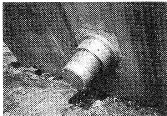
写真-4 ケーブル定着部
