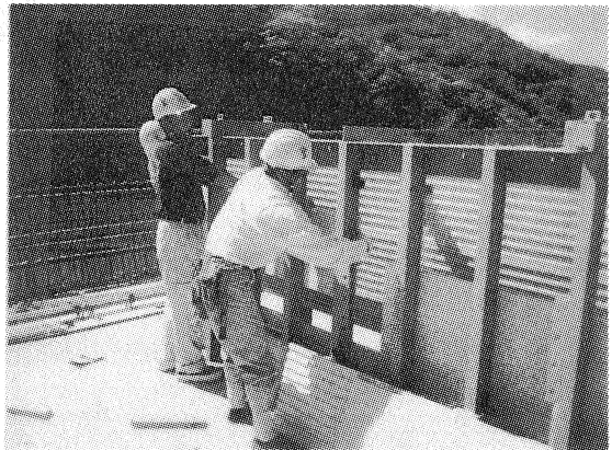
写真-2 PCaパネル取付状況
