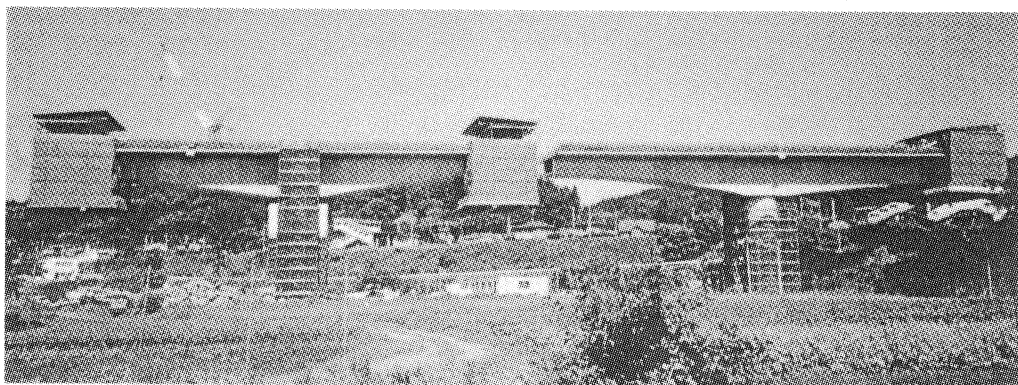
写真-1 施工状況 (P4、P5)
