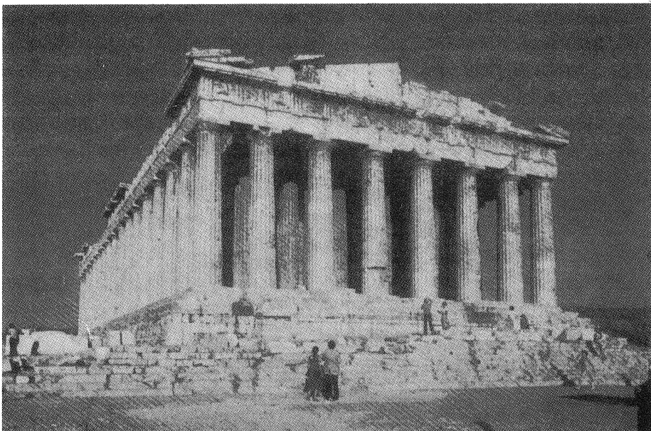
写真1 アテネのアクロポリスに建つパルテノン(紀元前5世紀)、円柱ドラムの接合には木製太納が使われ、壁石の接合には鉄製の錠が用いられた。
